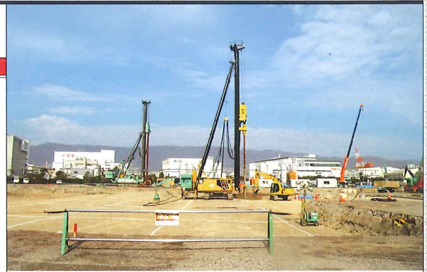
DNP堺工場建設工事
