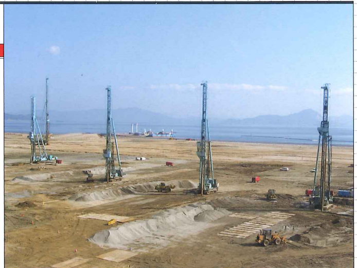
岩国飛行場(17)滑走路移設中央地区地盤改良工事
