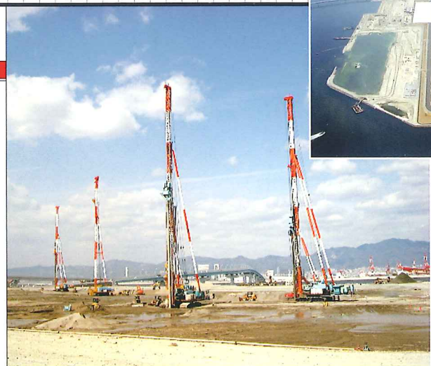
神戸空港地盤改良工事(その10)
