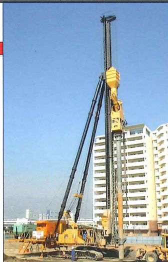
西宮マリーナパーク造成工事
