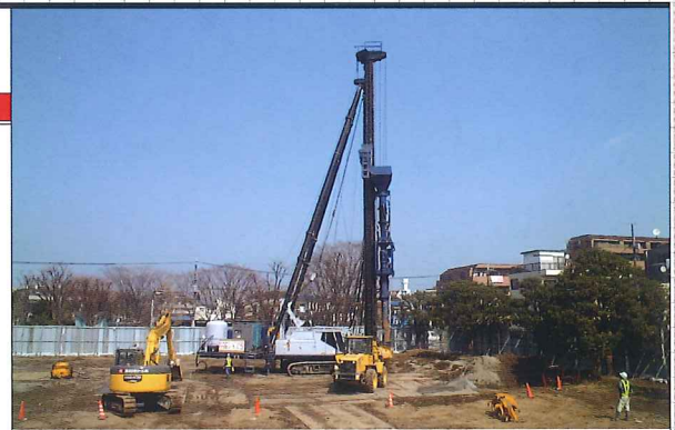
西新井第三団地立体駐車場(19-1)
