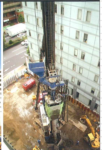
無量寿寺新築工事
