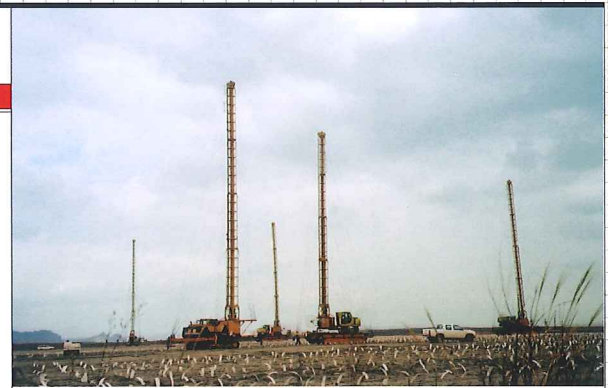
新門司地盤改良(8工区)工事
